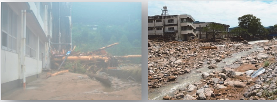
図-2 那智勝浦町立市野々小学校 (2011年 紀伊半島大水害)
