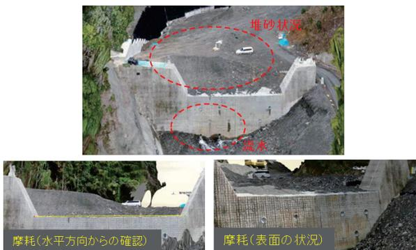
図-9 3次元モデルによる堰堤の変状推定
