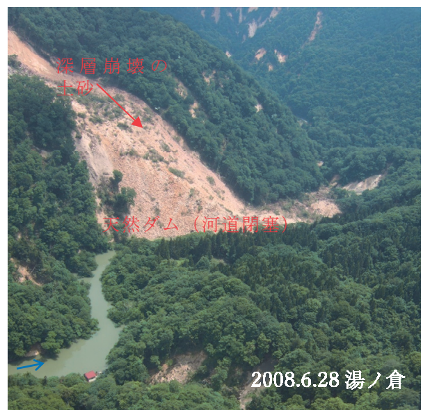
図-4 2008年岩手・宮城内陸地震で発生した湯ノ倉の河道閉塞（天然ダム）
