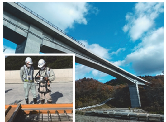
写真-3 東根川橋での段階確認状況
