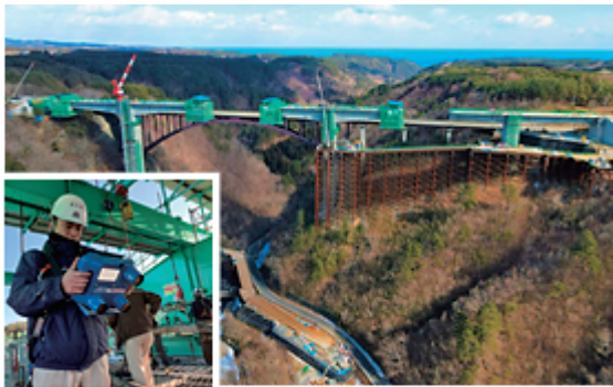
写真-8 新思惟大橋での配筋検査状況
