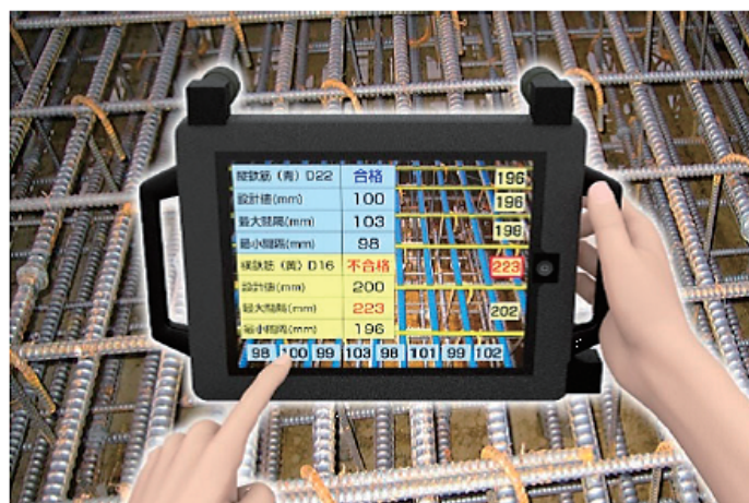
写真-1 配筋検査比較(左:システム利用、右:従来) 2)
