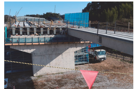
橋梁上部（床版・横組工）
