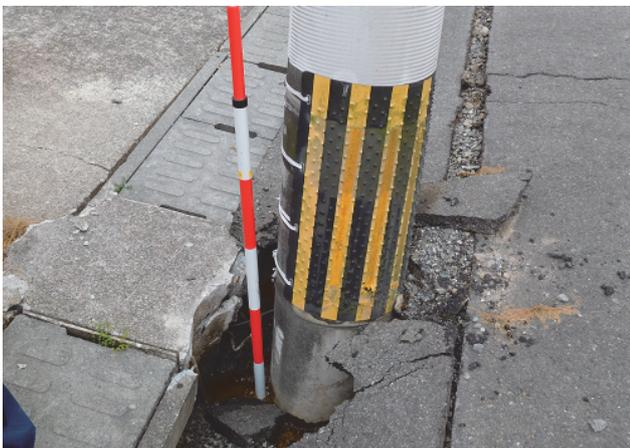
写真-2 地震による液状化で沈下した電柱
