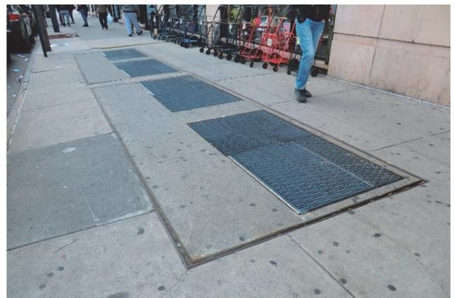
写真-6 トランス類の歩道下への設置事例 (ニューヨーク)
