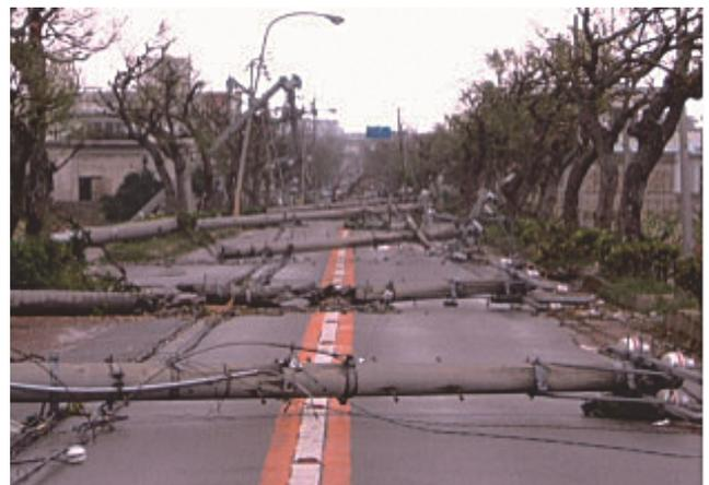
写真-1 台風で倒壊した電柱（宮古島市）
