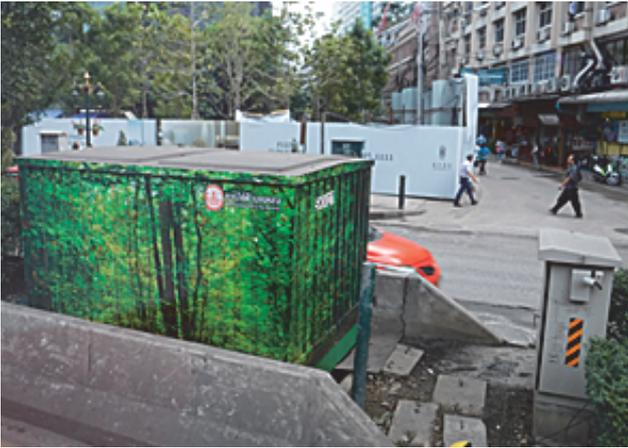
写真-3 中央分離帯に設置されたトランス類 (バンコク)
