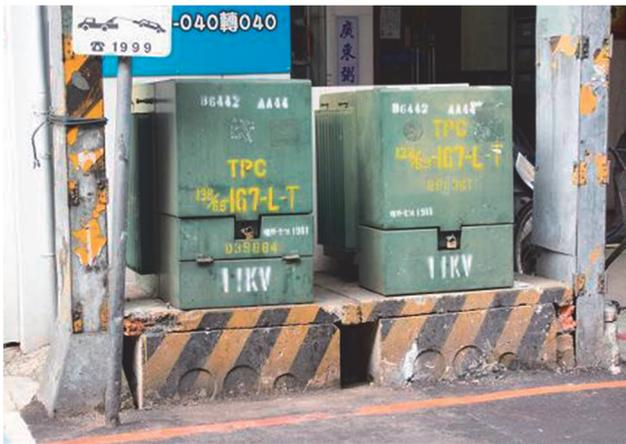
写真-4 嵩上げて設置されたトランス類 (台北)
