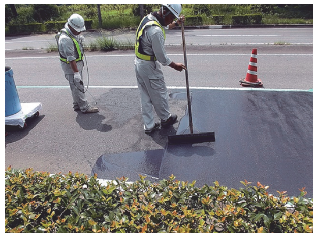
写真-2 薄層表面処理の施工状況（薄層表面処理C）
