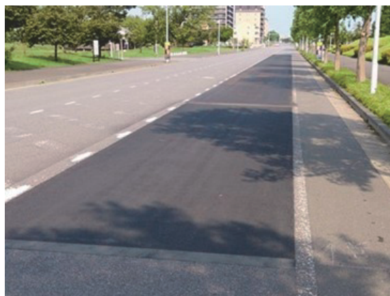
写真-1 試験施工による表面処理工法の評価検証の例
