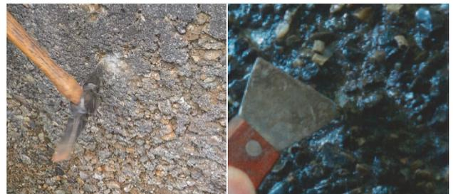
図-1 硫酸による劣化例(左)と二酸化炭素によると推定される劣化例(右)
