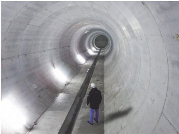
図-2 松川貯留管内部写真（内径約5m）
