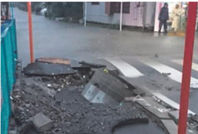
写真-1 下水道管路施設の被害の例（大雨による急激な雨水の浸入により、管内の水圧・気圧が急激に上昇した結果、マンホール・路面が損壊）
