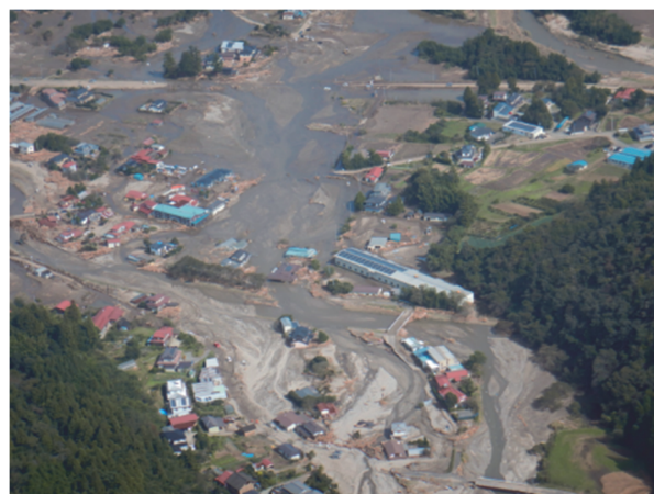
写真-1 土砂・洪水氾濫による被害状況 (宮城県伊具郡丸森町五福谷川 2019年10月17日撮影)
