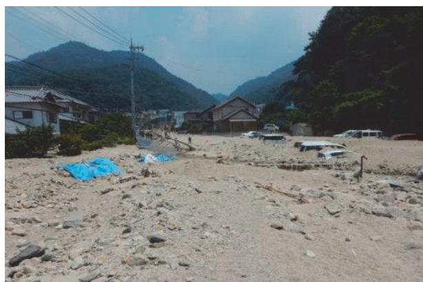
写真-2 土砂・洪水氾濫による被害状況 (広島県呉市大屋大川 2018年7月19日撮影)
