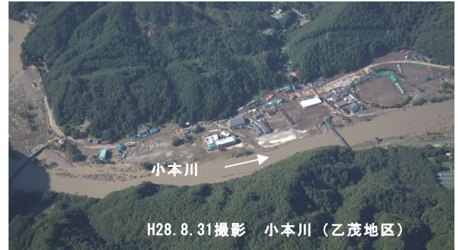
写真-1 小本川の被災状況
