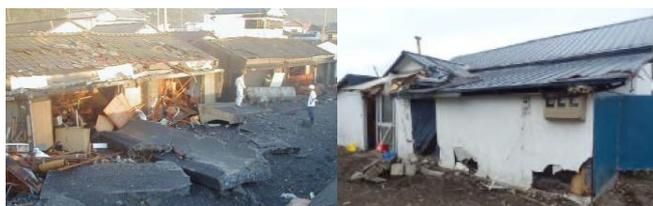
写真-1 越波による家屋の被害
