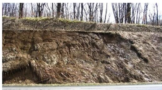
写真-2 凍結融解による斜面の崩壊
