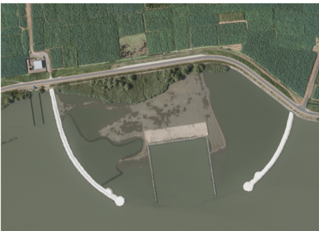
図-10 H区間（平成 29 年 3 月）整備中状況
