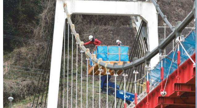
図-1 点検対象の吊り橋（橋長115m、幅員5m）
