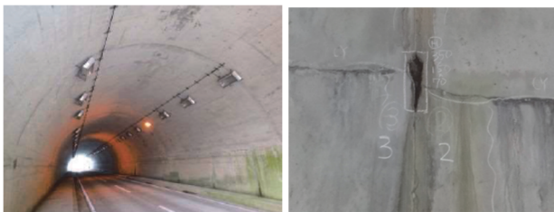
図-1 トンネル内とチョークにより手書きされた覆工スパン番号
