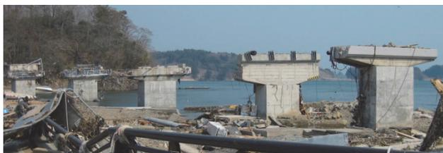
(a) 上部構造が流出して機能喪失した橋
