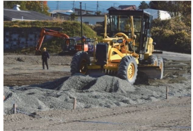
図-14 MC施工の効果の計測状況
