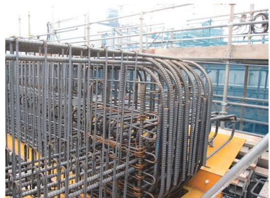
図-1 鉄筋コンクリート橋脚配筋状況の例
