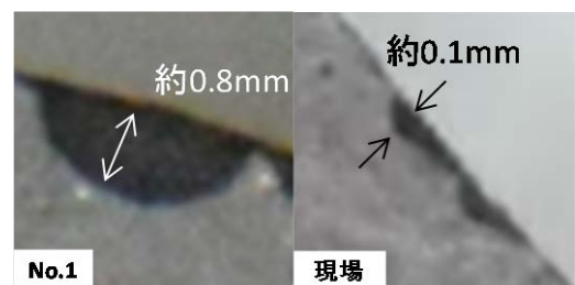
写真-4 PC鋼棒の断面の欠損箇所
