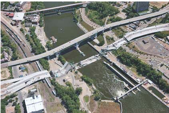
写真-1 崩落後のI-35W橋の全景 (米国ミネソタ州交通局ホームページより)
