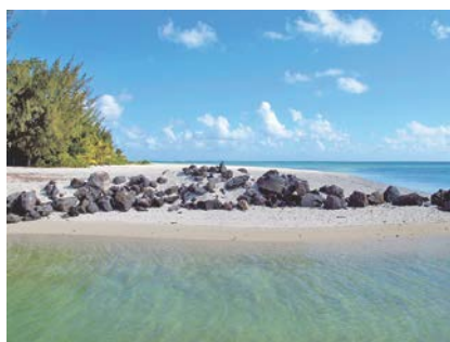
写真-2 航路に沿って伸びたjettyの南側面を北側から望む
