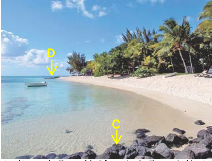
写真-7 突堤Cの付け根から突堤Dへと伸びた汀線状況
