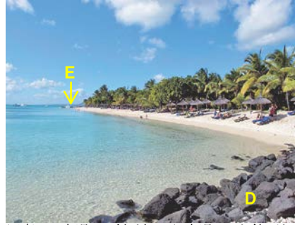
写真-8 突堤Dの付け根から突堤Eへと伸びた汀線状況
