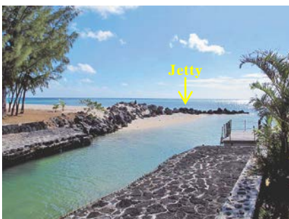
写真-1 プレジャーボートの出入り口として使われている航路と南側に伸びたjetty
