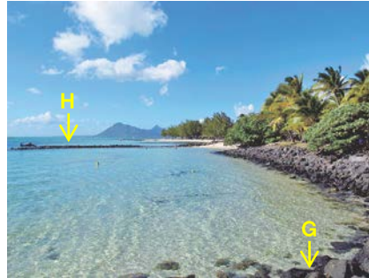
写真-11 棧橋Gの北側直近に設置された火成岩を用いた護岸
