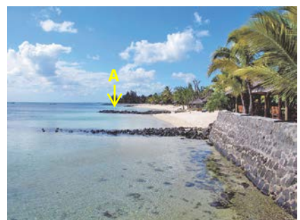
写真-3 航路の北側直近で波に曝された直立護岸
