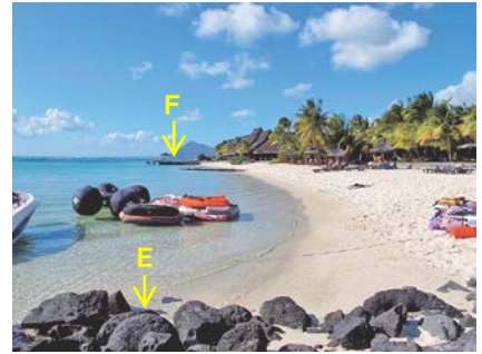
写真-9 突堤Eから北側に伸びたフック状汀線
