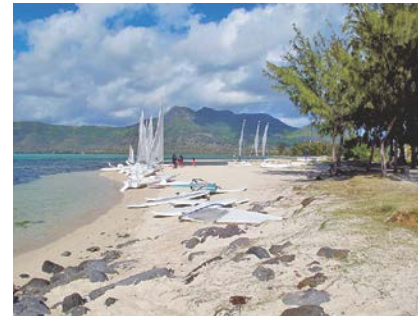
写真-13 砂嘴北端部で汀線固定のため設置された捨石
