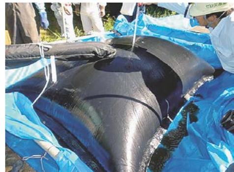
写真-2 底泥の袋への充填状況
