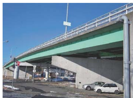
写真-1 試験橋梁「あやめ跨線橋」
