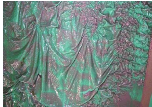
写真-2 塩化ゴム系塗料の膨潤・軟化状況
