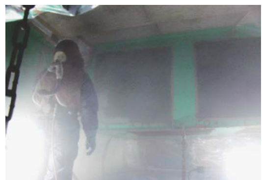
写真-3 オープンプラスト工法の作業状況
