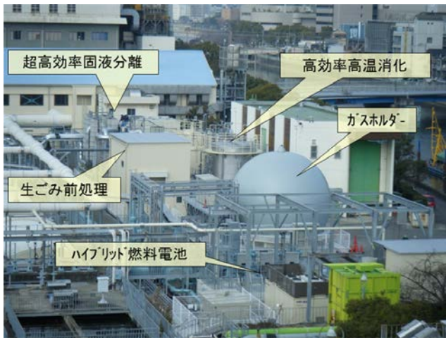
図-3 実証研究施設 (超高効率固液分離技術を用いたエネルギーマネジメントシステムに関する実証研究)
