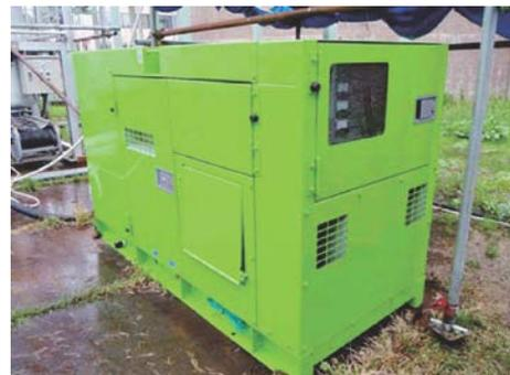
写真-1 実証試験で使用した発電システム（堀之内浄化センター）
