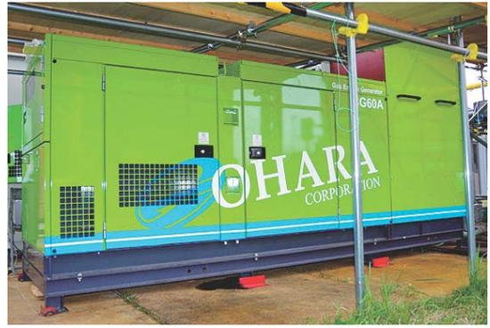
写真-3 BG60 バイオガス発電機（新津浄化センター）
