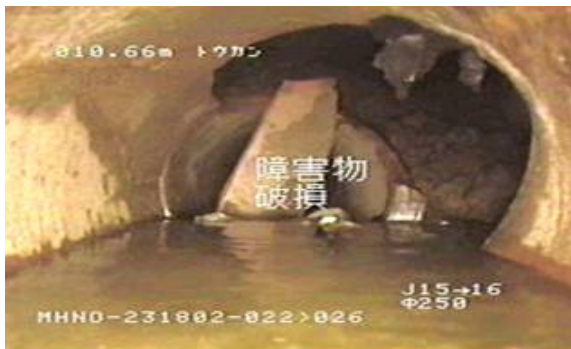
写真-1 管路の破損の状況
