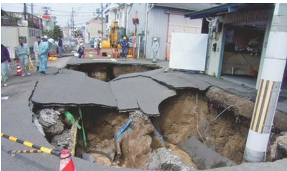
写真-2 道路陥没の状況
