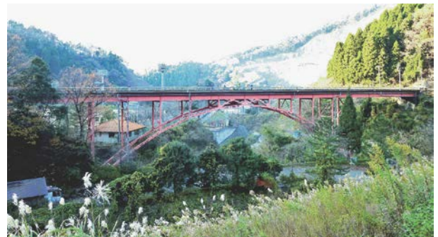
写真-1 対象橋梁の全景
