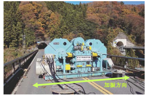
写真-2 起振機の設置状況 (アーチ支間中央部、橋軸直角方向加振)
