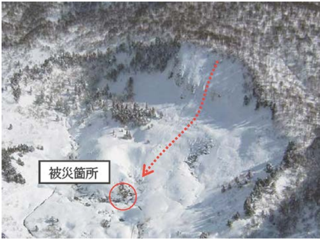
写真-4 玉川温泉災害現場全景(撮影：秋田県)
