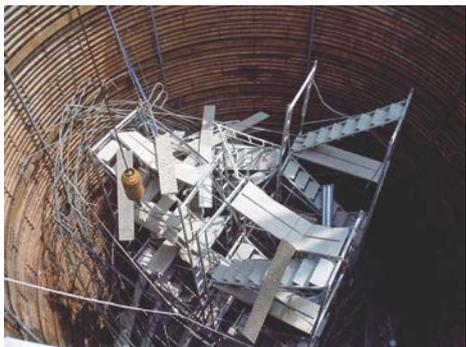
写真-4 深礎基礎の鉄筋崩落事故
