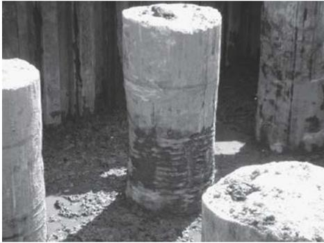
写真-3 場所打ち杭の細りの事例
