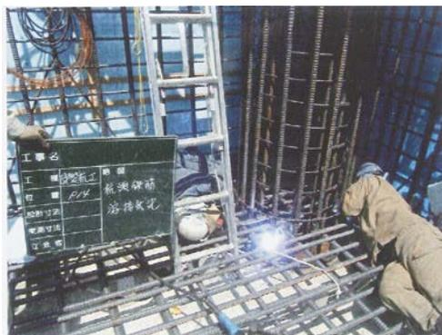
写真-1 杭外周部への溶接による補強鉄筋の施工例
