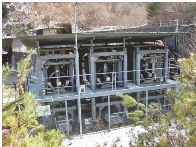
写真-2 流砂観測施設
