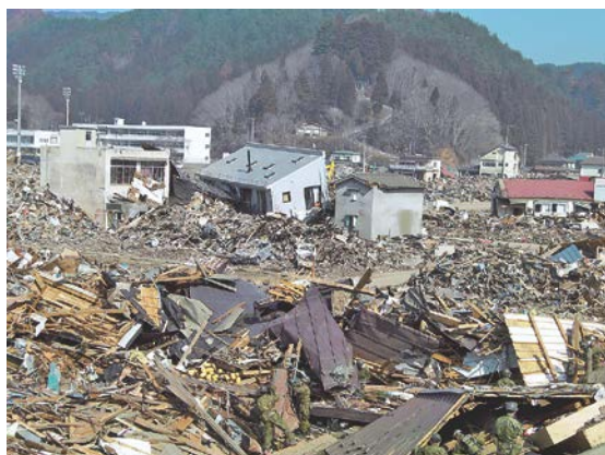
写真-1 津波による建築物被害
