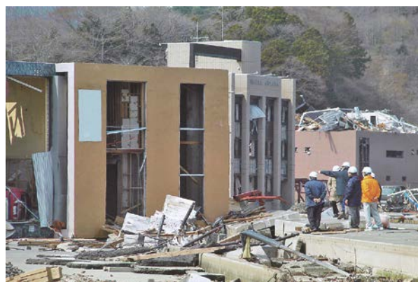
写真-2 建築構造基準委員会による現地調査（女川町）
