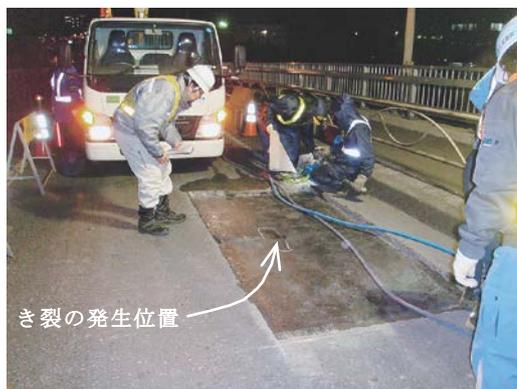
a) 舗装を剥がしたデッキプレート表面の状況
