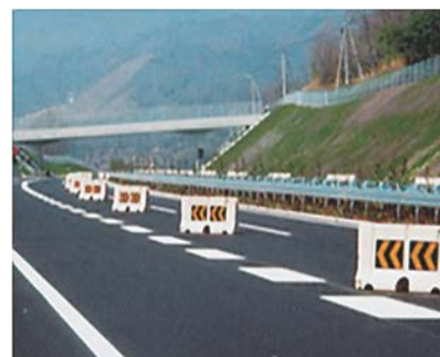
写真-7 壁ブロックの単独設置例 2)
