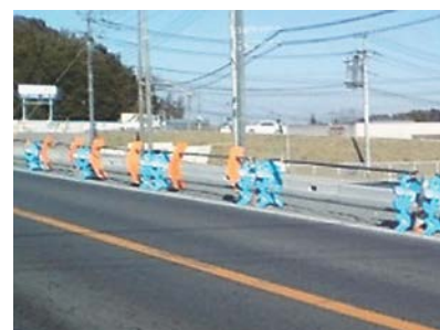
写真-3 工事用バリケードの設置例
