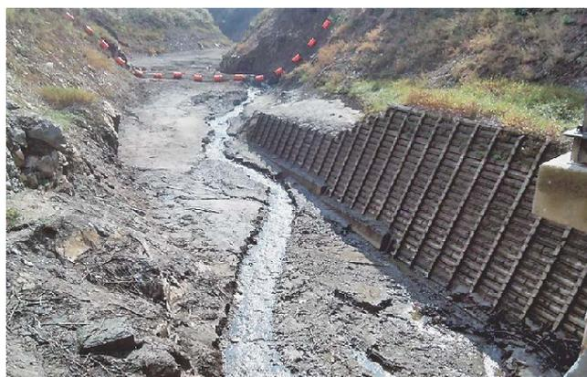
図-1 水位低下した農地防災ダムにおける細粒土砂の侵食状況
