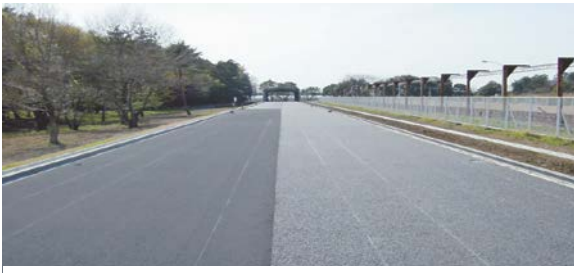
写真-4 施設の路面状況
