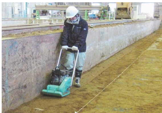
写真・3 小型機械による締固め状況（例）
