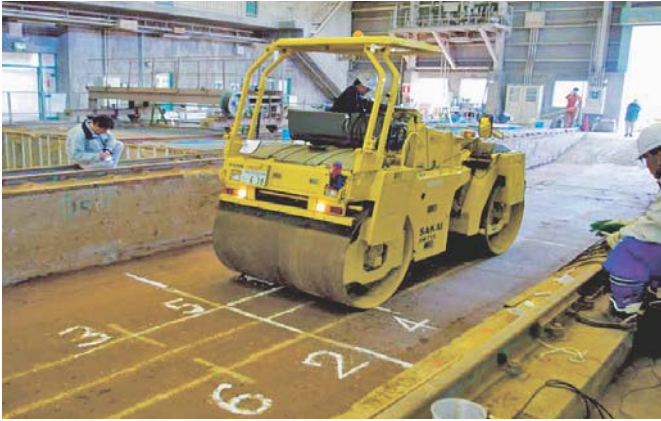
写真-2 大型機械による締固め状況 (例)
