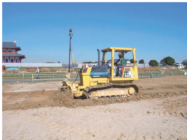
写真-2 3D-MC ブルドーザーによる造成
