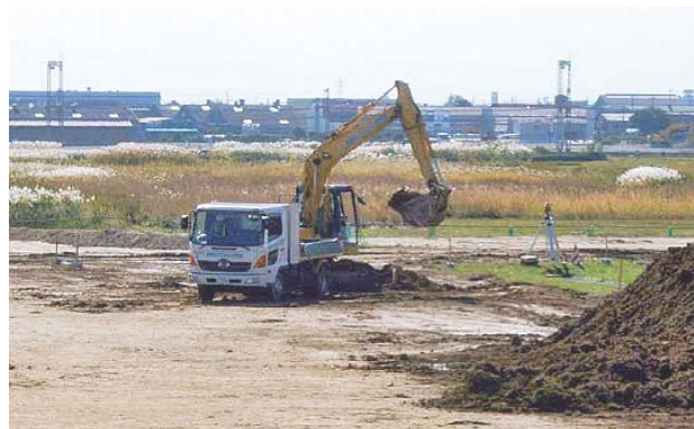
写真-4 3D-MG バックホウによる掘削
