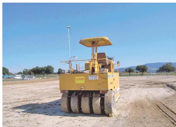
写真-6 タイヤローラによる施工
