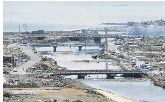
写真-2 掘割り河道に架かる小規模橋梁 (南三陸町八幡川)
