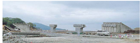
写真-1 ポステンT桁が流失した橋梁 (沼田跨線橋)
