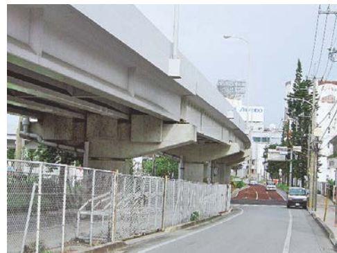
写真-5 空港周辺の景観保持のため表面被覆工を施した橋梁の上・下部構造
