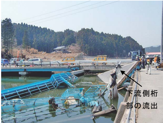
写真-8 一部区間の上部構造流出（水尻橋）
