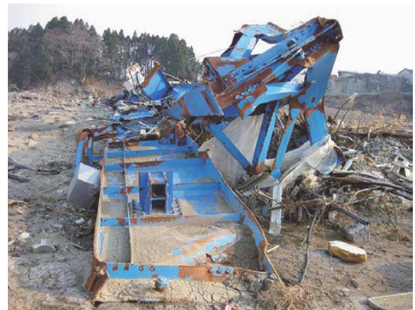
写真-7 小泉大橋の流出した桁の状況
