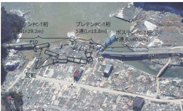
写真-9 歌津大橋周辺の流出状況 （国土交通省東北地方整備局提供 2011年3月19日撮影）
