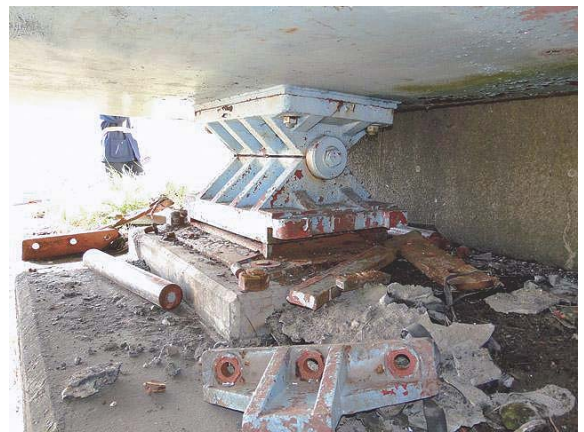
写真-2 国田大橋における可動支承のローラーの抜け出し
