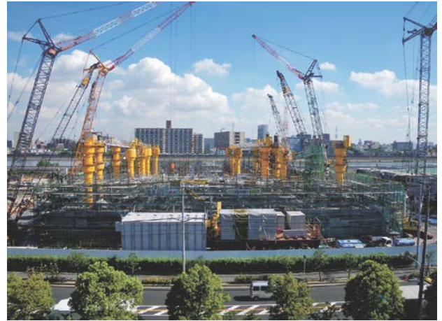
写真-2 ニューマチックケーソン施工状況 (平成22年8月撮影)
