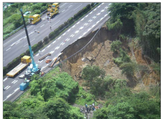
写真-1 被災状況
