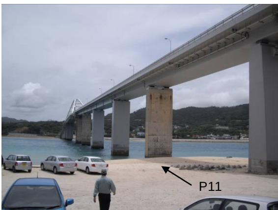
写真-2 調査対象の橋脚
