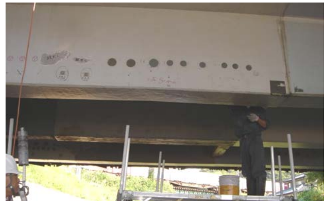
図-1 表面被覆材健全性評価のための実橋試料採取の例
