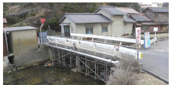
写真-1 撤去前の状況
