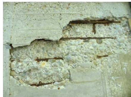
写真-2 撤去前の床版下面状況
