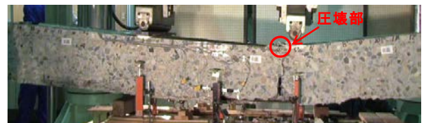
写真-5 荷重試験終了後の状況 (B面)
