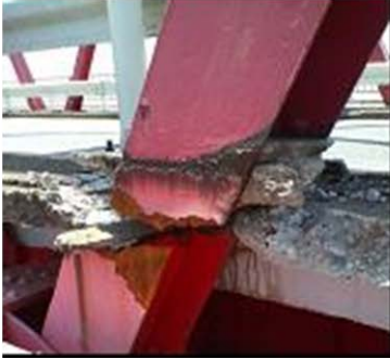
写真-3 引張斜材の腐食破断事例
