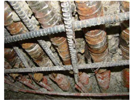
写真-5 PCケーブルの損傷事例
