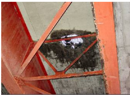
写真-1 コンクリート床版の抜け落ち
