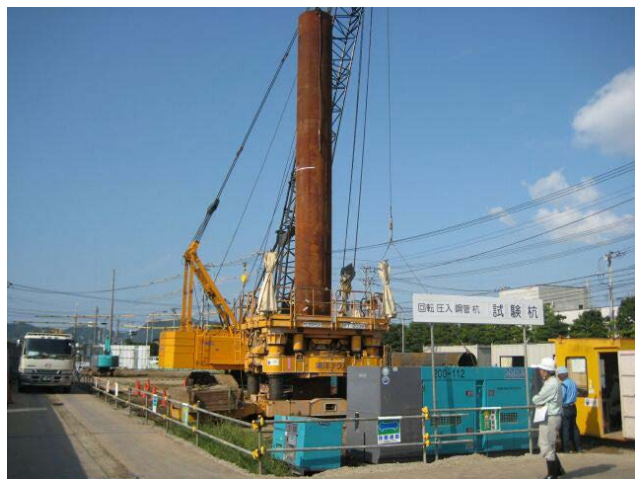
写真-2 回転圧入鋼管杭基礎施工状況
