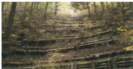
写真-5 (写真-4と同じ場所) 植生の自然侵入がみられる(H15) (国土交通省木津川上流河川事務所)
