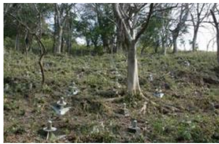
写真-6 樹木を残して斜面の安定を図る鉄筋挿入工法による斜面对策 (国土交通省六甲砂防事務所)
