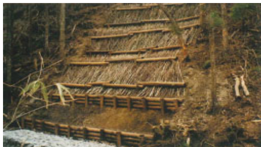
写真-4 間伐材による山腹基礎工の施工 (H6) (山腹基礎工により表面侵食を防止)
